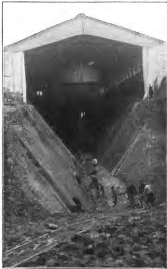
Fig. 8. — Zur Ballonhalle umgeänderte Artillerie-Reitbahn in Toul.
